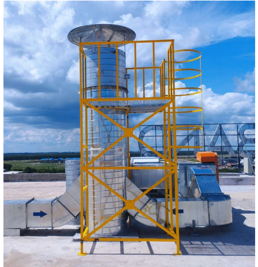
LẮP ĐẶT SÀN THAO TÁC VÀ CẢI TẠO ỐNG THOÁT KHÍ CĐT: CÔNG TY TNHH TOPBAND SMART VIỆT NAM Địa điểm: Đồng Nai
